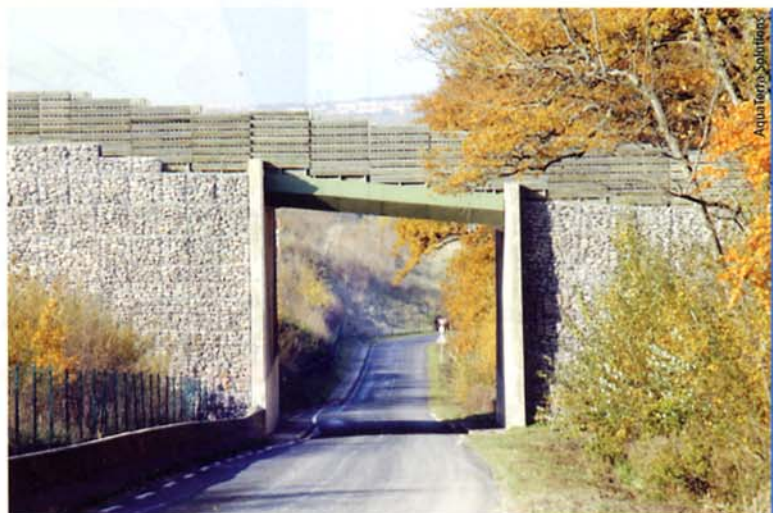
▶ Soutènement d'un passage à faune
