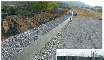
Après réglage et compactage des remblais, une nappe de géotextile de renfort est mise en place avant la pose d'une nouvelle rangée de gabions.
